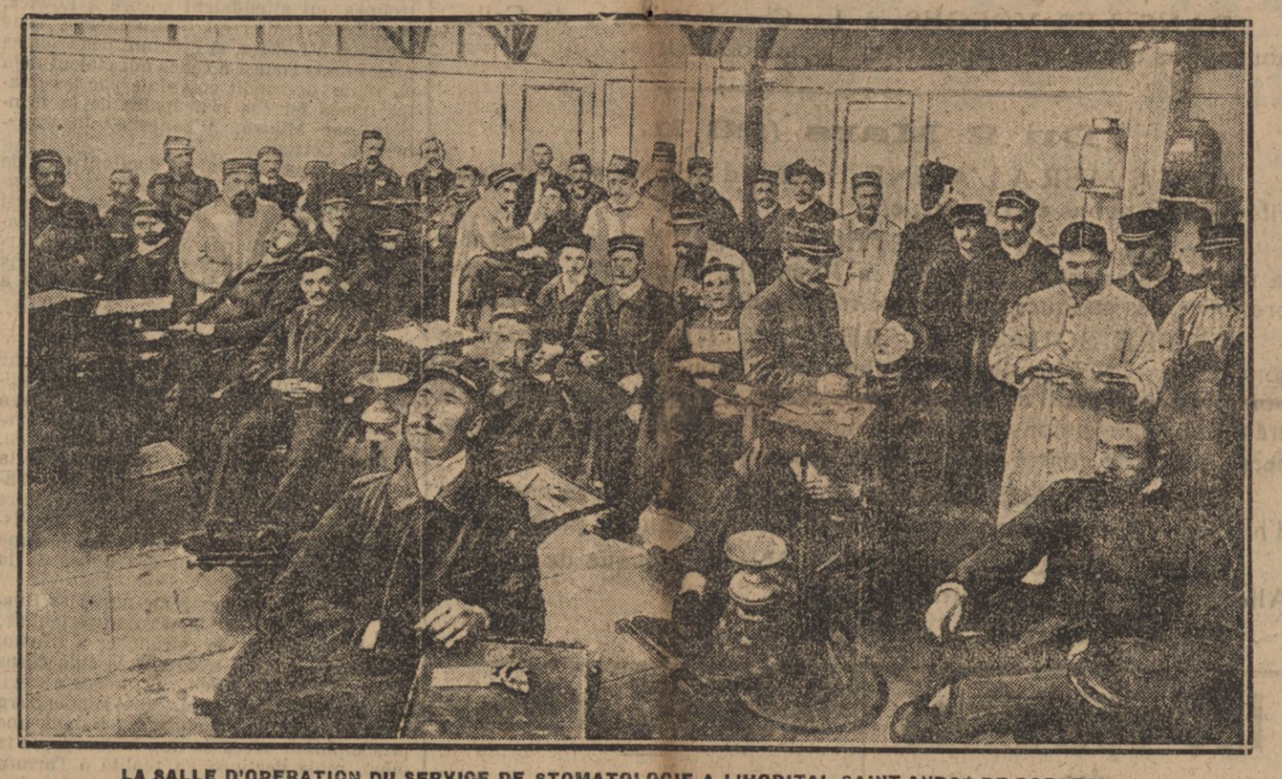
LA SALLE D'OPERATION DU SERVICE DE STOMATOLOGIE A L'HOPITAL SAINT-ANDRE DE BORDEAUX
