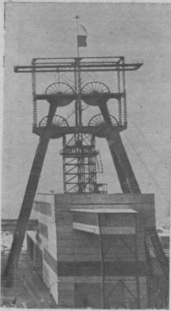
Wieża wyciągowa nowej Kopalni „Jastrzębie”
