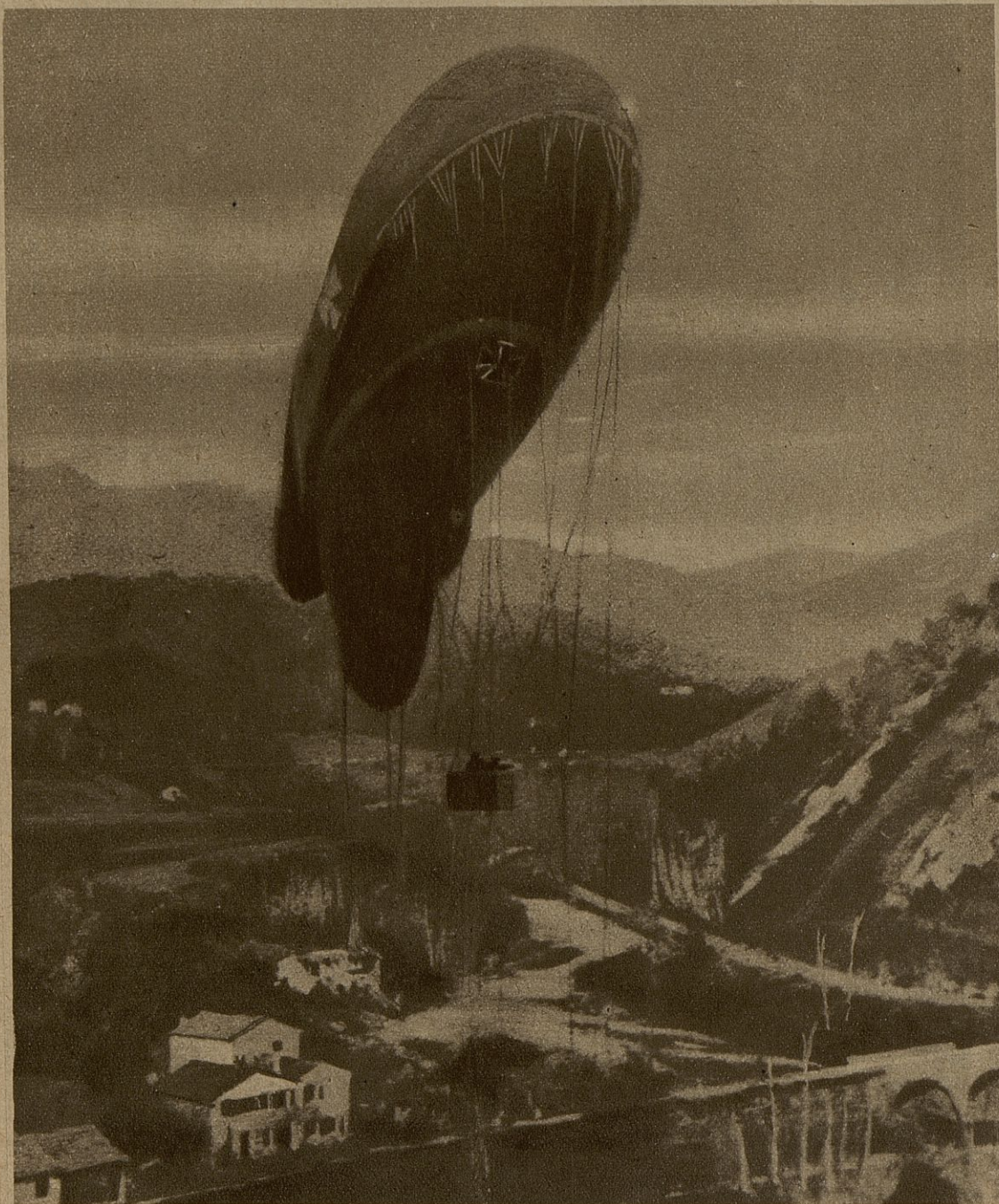
Cette photographie, faite par un Boche en Italie, nous fait assister au travail d'un drachen allemand. Planant au-dessus d'une riante vallée de la Haute-Piave, les observateurs, qu'on voit dans la nacelle, étudient le secteur qui les entoure pour régler le tir de leurs batteries établies dans le voisinage.
