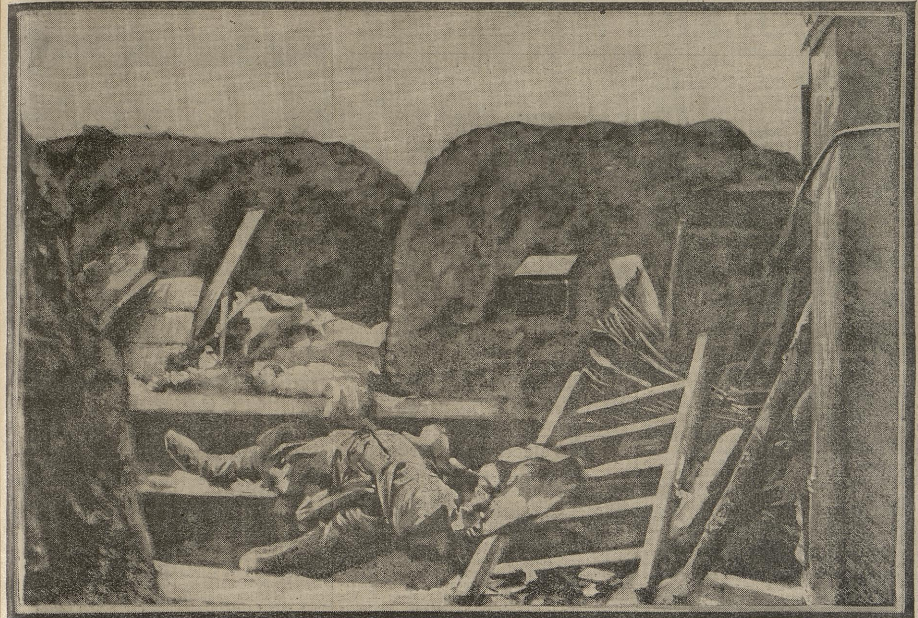
Cette tranchée allemande conquise par les Français est déjà loin du front. Elle fut, en effet, enlevée de haute main sur un point où les ennemis reculèrent à suffisante distance pour qu'on ne puisse plus craindre leur retour. La tranchée va donc être comblée, car, au surplus, elle est inutilisable. Mais, avant l'arrivée des terrassiers-soldats, un photographe-poilu a pris la dernière pose de ce Saxon, renversé sur le marchepied d'où il regarda venir la mort.
