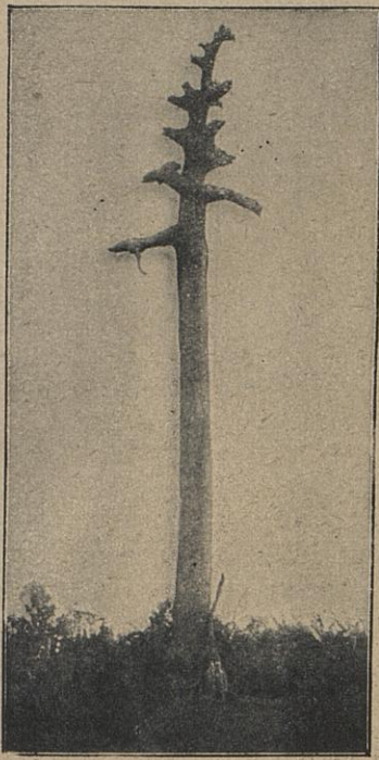
Die ersten eingetroffenen deutschen Photographien aus Deutsch-Ostafrika im Kriege: Eine Ersatz-Antenne der Funktelegraphie (nach Zerstörung des Funkturm in Butoba).
