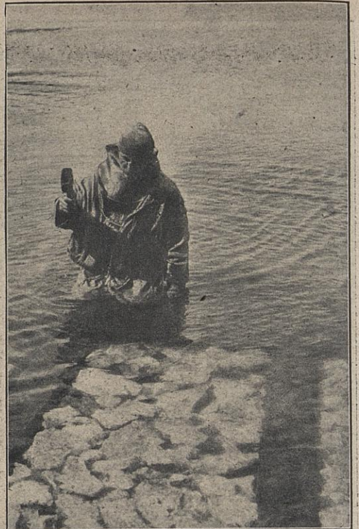
Ausbesserung der Gleitbahn für Wasserflugzeuge durch einen Taucher in einer Flugstation der österreichisch-ungarischen Marine.
