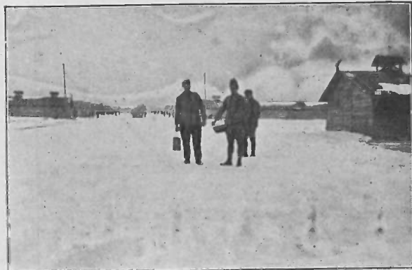
AU CAMP DE SAINTE-TANCHE (JANVIER 1918). La corvée de soupe. Au fond, les baraquements.
