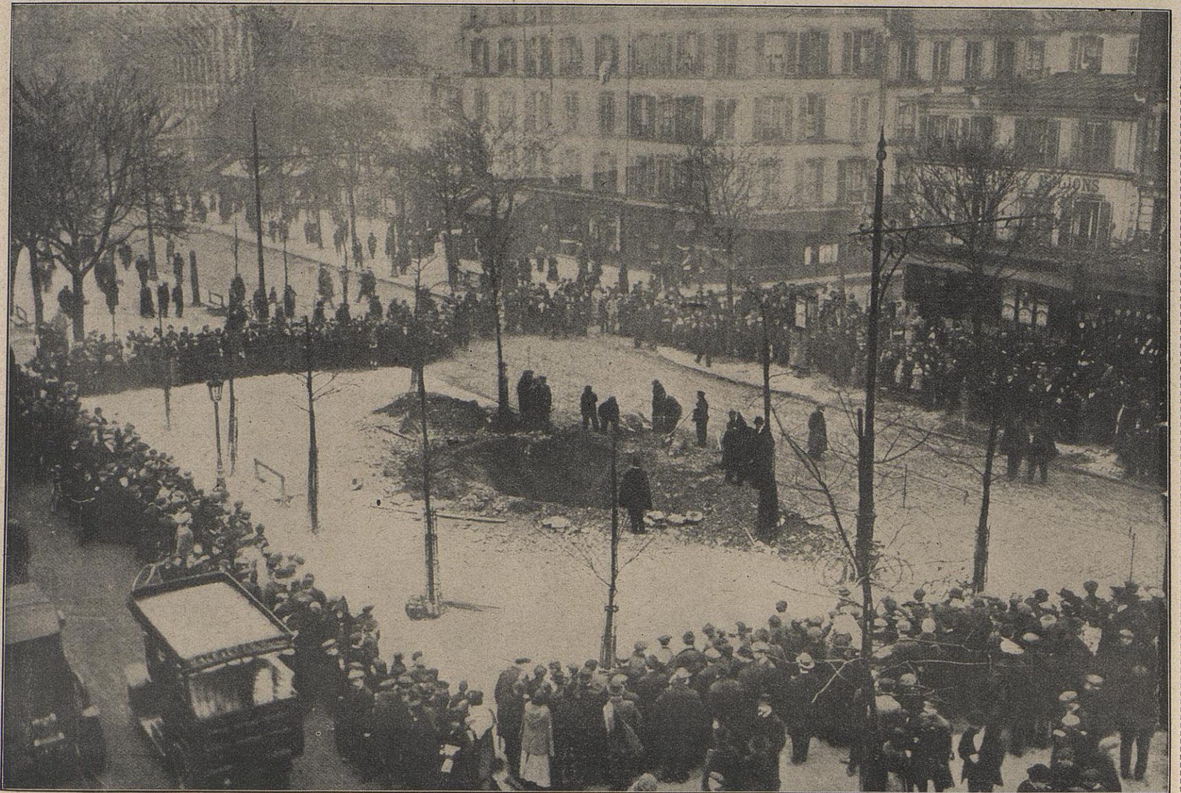
Vom Zeppelin-Angriff auf Paris: Der Trichter, den eine Bombe in das Straßenpflaster gerissen hat, wobei der Tunnel der Untergrundbahn beschädigt wurde. Aus einer englischen Zeitschrift.
