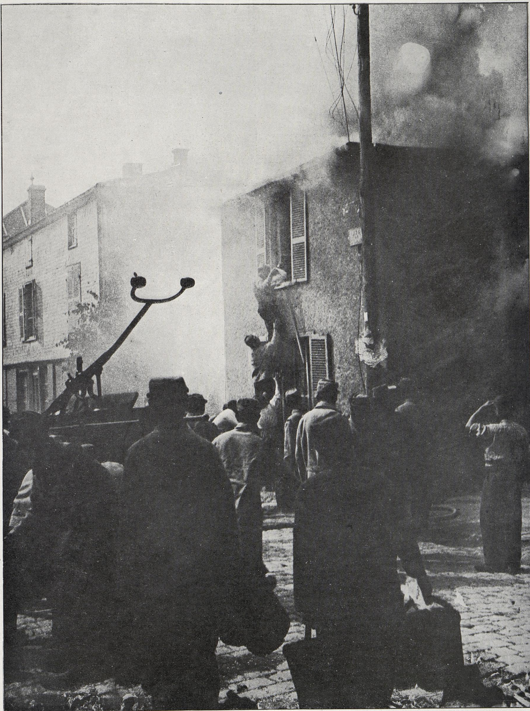
UN INCENDIE DANS UN VILLAGE DU FRONT. — C'est à Suippes. Quelques obus incendiaires ont atteint le but innocent que les Allemands s'étaient proposé. Mais nos soldats disposent du matériel pour combattre efficacement le fléau. Les pompes sont en batterie — et les humbles chaumières seront, non pas indemnes peut-être, mais du moins sauvées. Quelques toitures crevées, quelques façades éventrées et léchées par les flammes, tel est le bilan de l'opération, bilan sans gloire et sans nécessité, qui affirme simplement, une fois de plus, le vandalisme de nos irréductibles ennemis.
