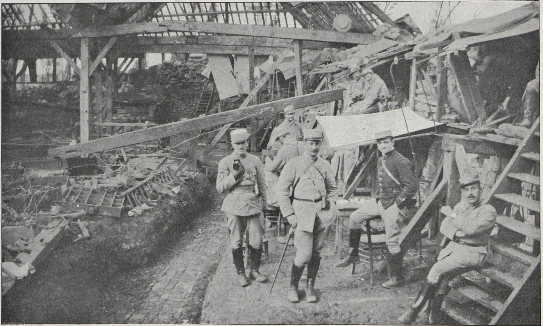
● UNE TRANCHÉE SUSPENDUE DANS LE NORD. — C'est sur la Scarpe qu'elle a été construite récemment pour remplacer la tranchée construite en plein sol que l'inondation rendait inoccupable. Elle se dresse sur la rivière comme un balcon et sa solidité égale son pittoresque.
