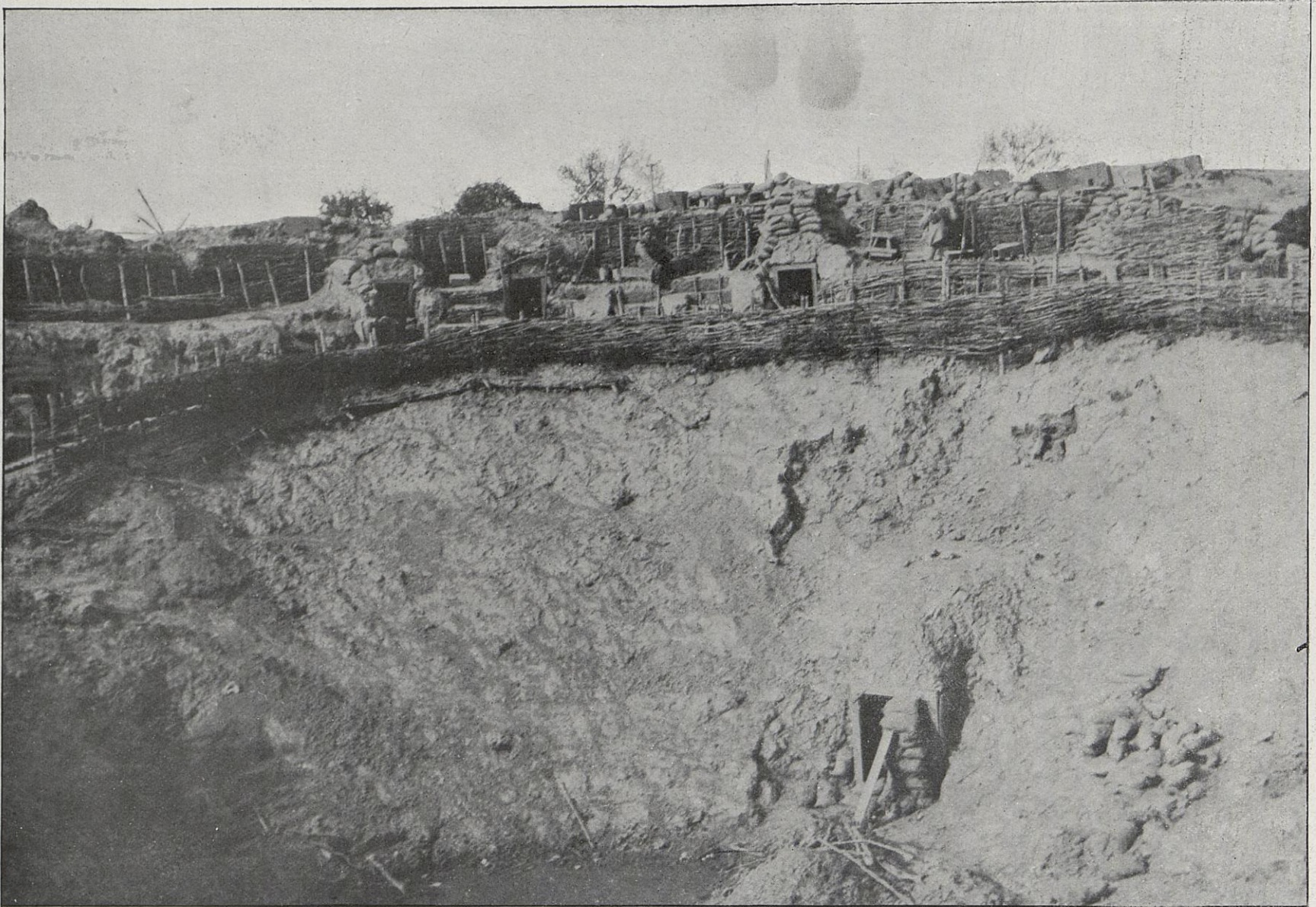
UN ENTONNOIR ORGANISÉ EN LORRAINE. — Un «entonnoir organisé» c'est une expression qui revient souvent dans nos communiqués. Cette photographie permettra de se rendre compte de ce qu'elle exprime : galeries, abris, gabions, sacs de sable et le reste ; un entonnoir organisé, c'est en quelque sorte, comme il est facile de le voir ici, une position devenue inexpugnable.
