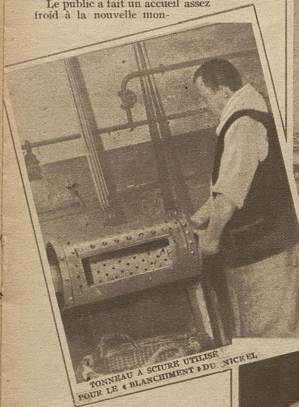
TONNEAU À SCIERE UTILISÉ POUR LE « BLANCHIMENT » DU NICKEL.
