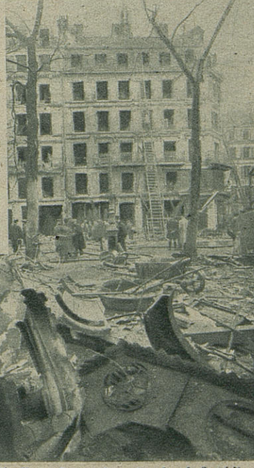
Rue de Rivoli. — Par gothas, bombe de 300 kilos.
