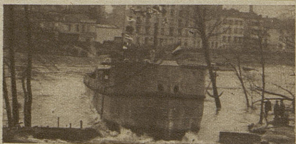
A Neuilly-sur-Seine, le lancement du Comron 1 , le premier navire de mer en ciment armé, construit pour la France.
