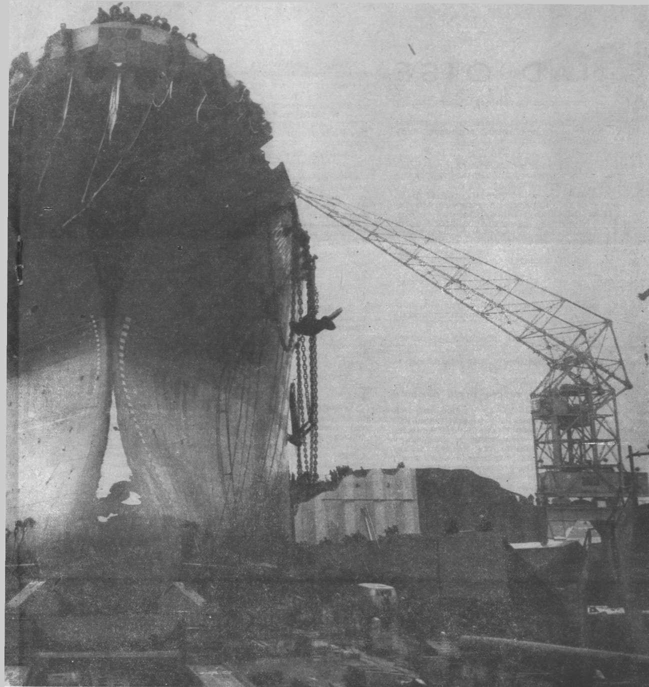
pochylni, świadczą sąsiednie zabudowania i urządzenia techniczne oraz miniaturowe sylwetki robotników
