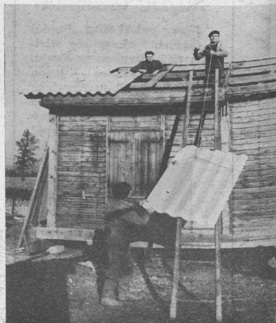
Pan Józef Sycz pracuje nad budową własnego domku, przerobionego z baraku.
