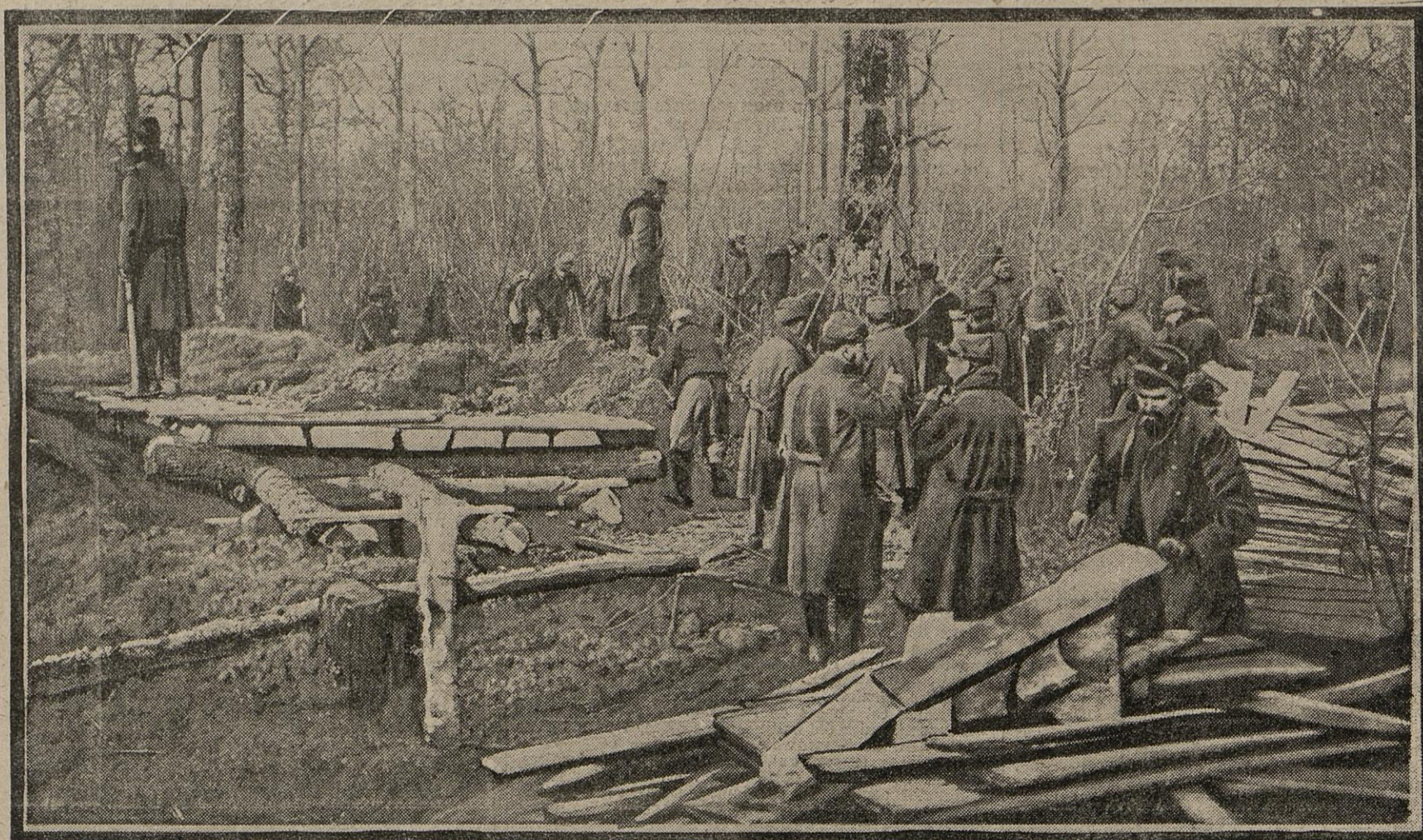
Ce n'est pas — toujours — parce qu'on est loin des tranchées qu'on n'a plus absolument rien à craindre. A l'arrière, nos soldats ont la précaution de bâtir des abris souterrains où ils peuvent attendre en toute impunité l'heure de retourner au combat.
