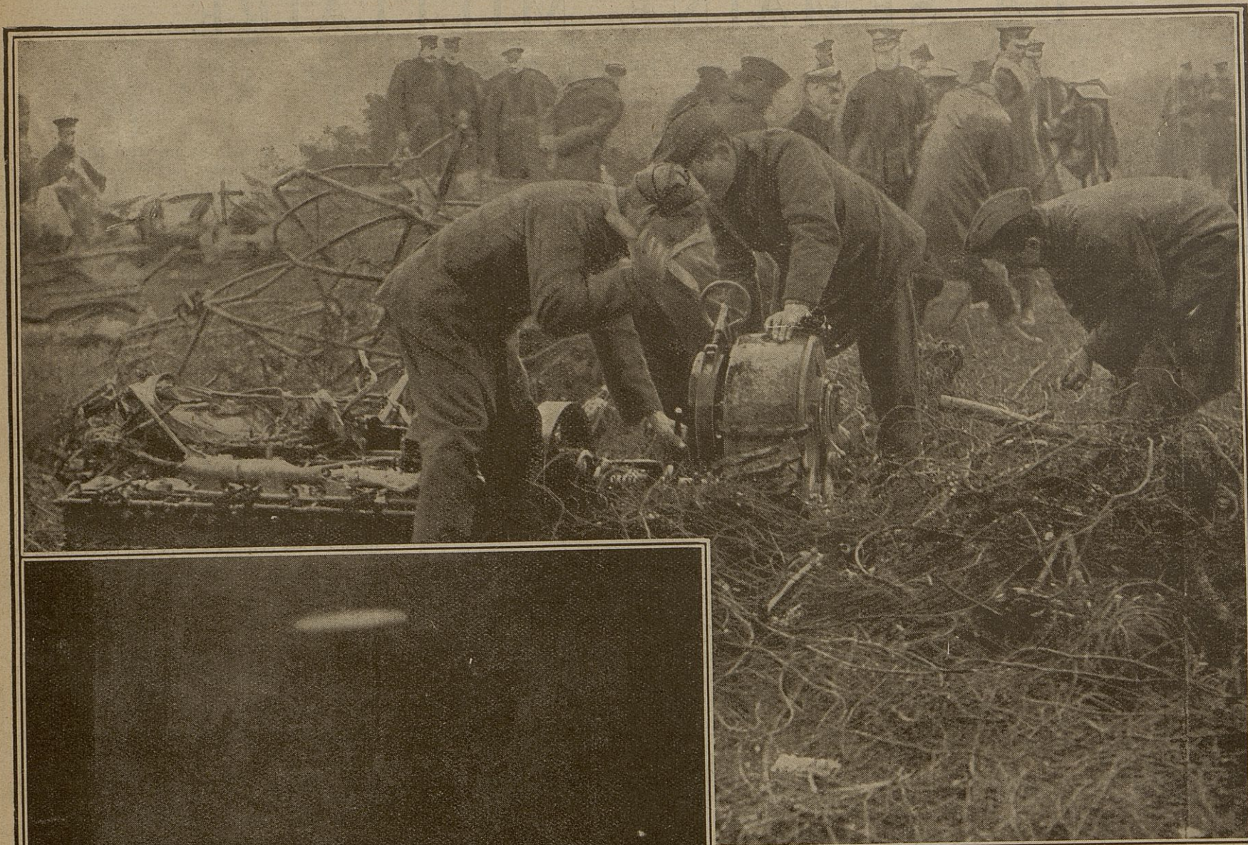
Sur le sol, les ruines du zeppelin détruit par le feu, carcasse et machines, forment un tas compact. Des soldats, triant ces débris, en retirent le moteur.
