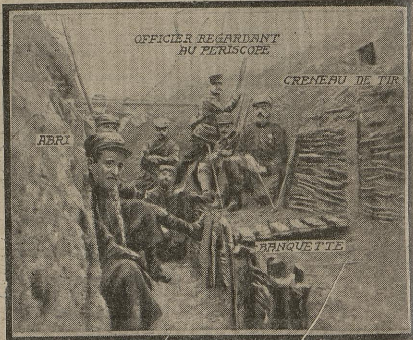
LA TRANCHEE MODELE Le créneau de tir, la banquette, l'abri, le poste de périscopie, autant d'expressions qui reviennent souvent dans les récits de guerre. On en voit ici l'illustration dans une tranchée qui passe pour un modèle du genre.
