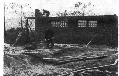
Mieszkańcy Mielezki nie tylko poszerzają prawie dwukrotnie zasięg swoich wiejskich wodociągów, ale modernizują je, budując m. in. nową hydrofornię
