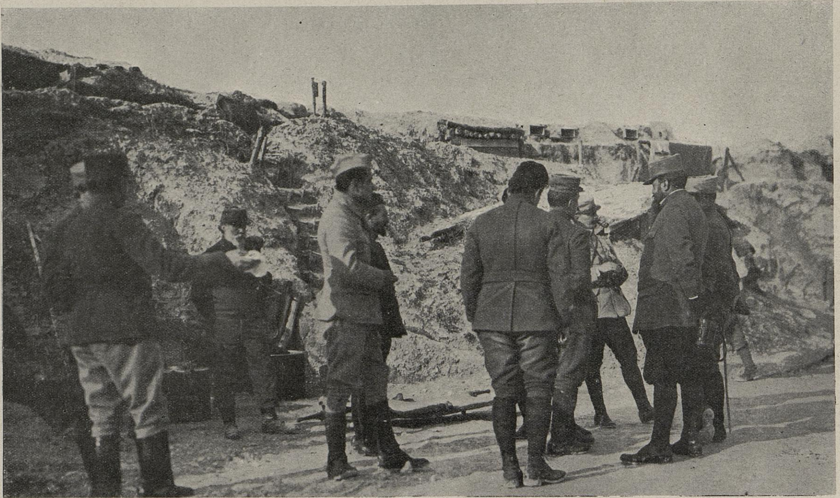
Officiers dirigeant des travaux de terrassement dans les tranchées de première ligne.
