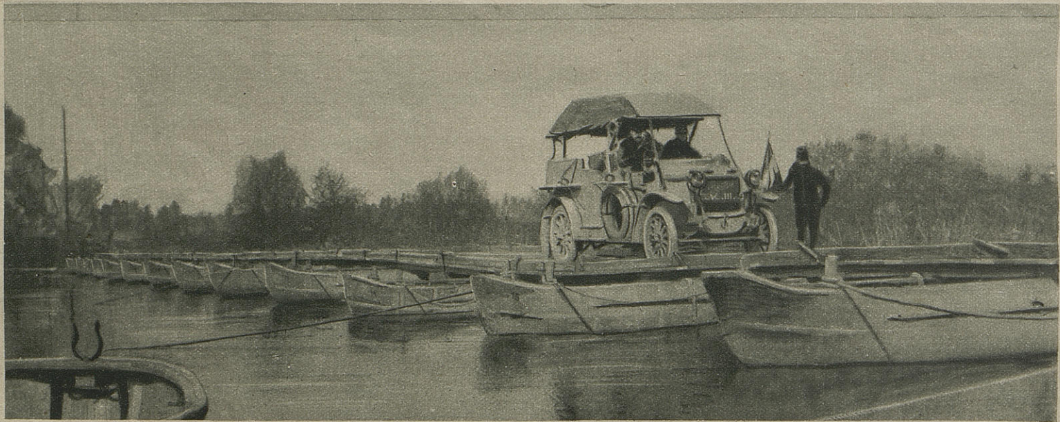
LE PASSAGE D'UNE AUTOMOBILE CONVOYEUSE SUR UN PONT DE BATEAUX
