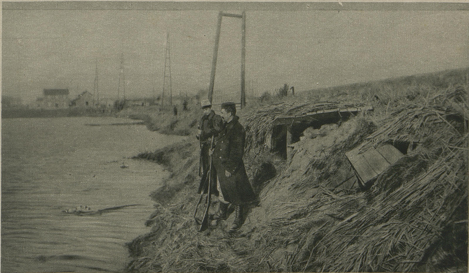
L'YSER DÉBORDÉE PAR LES INONDATIONS
