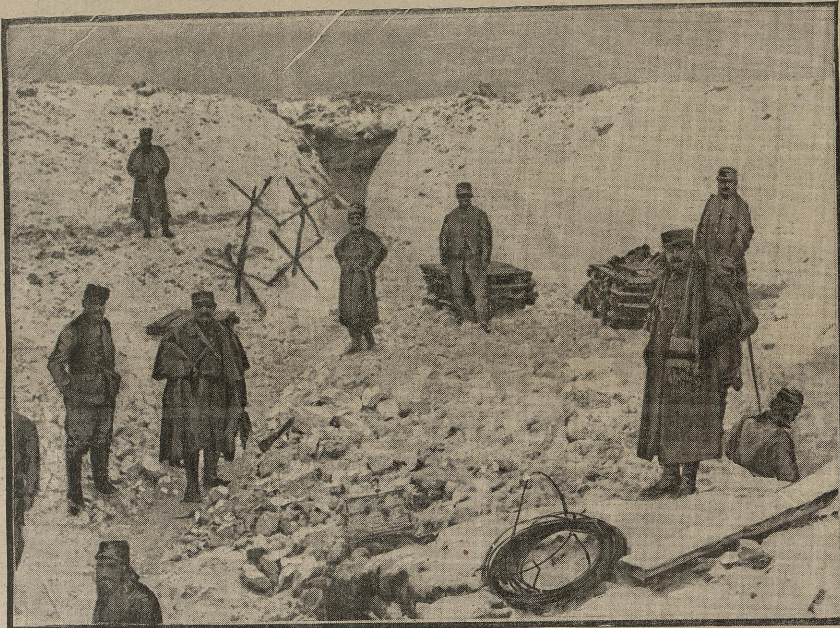
Cette excavation fut produite par l'explosion d'une mine souterraine. Nos soldats, qui l'occupent aujourd'hui, ont déjà commencé l'installation de leurs tranchées. On aperçoit, en effet, au second plan, l'entrée d'un boyau et les premiers réseaux de fils de fer barbelés.
