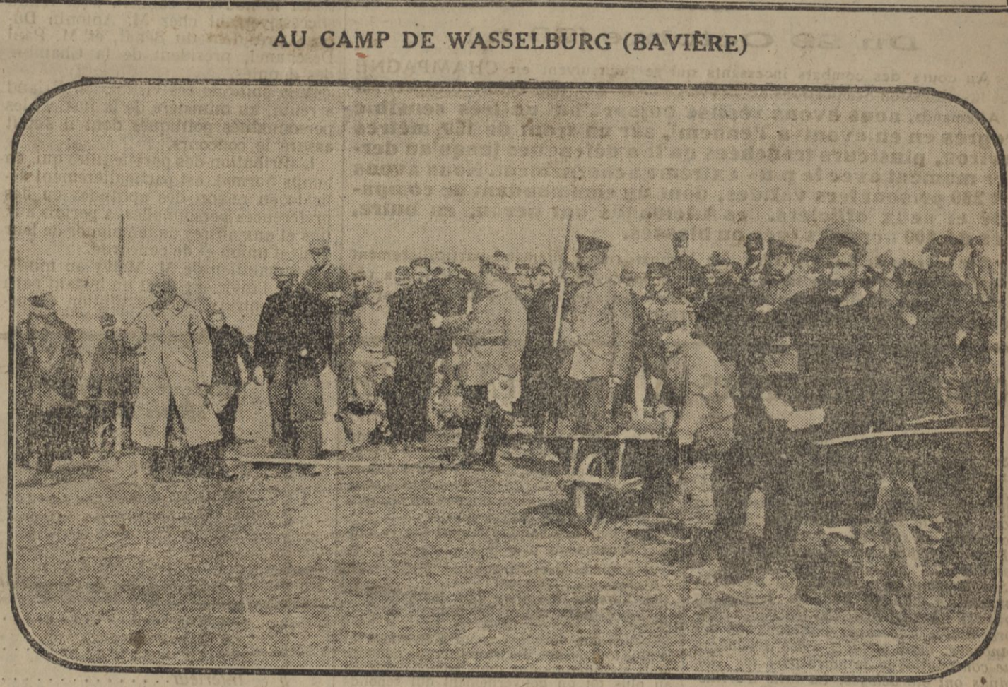
La construction d'une nouvelle route par des prisonniers français. Le nivellement du terrain avant l'implémentation
