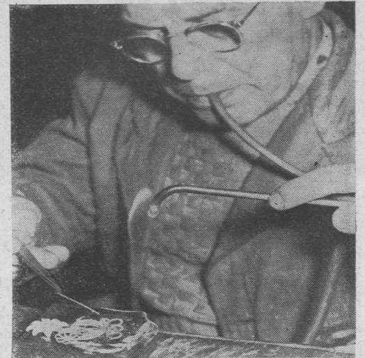
W ogniu palnika łączy się poszczególne elementy broszki. Jak to się dzieje, że mistrz Horak nie stopi cieniutkich drucików ozdoby? Na to pytanie nie ma odpowiedzi — tajemnica zawodowa
