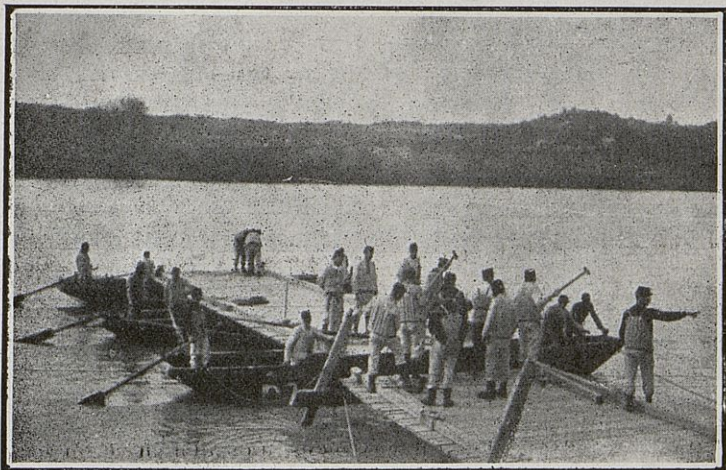
LA TRAVERSÉE D'UNE RIVIÈRE Nos pontonniers construisent la tête d'un pont flottant.
