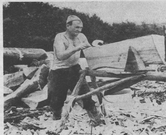
Korowanie papierówki jest jedną z niewielu prac wykonywanych w przemyśle drzewnym ręcznie
