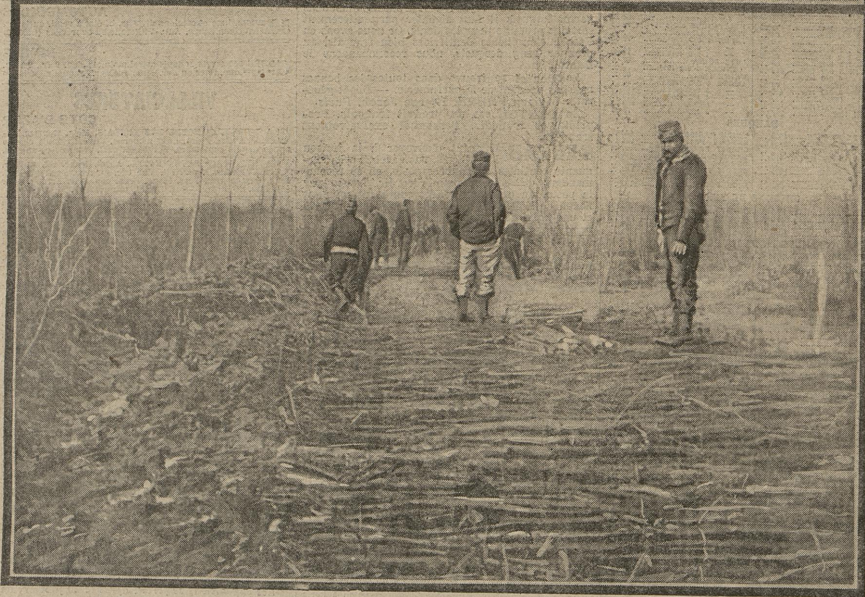
Nos sapeurs travaillent ferme actuellement dans l'Est. Ils mettent surtout en état les routes que les pluies ont rendu impraticables. Notre photographie représente un détachement de soldats du génie occupés à la réfection d'une voie que doit emprunter une colonne d'artillerie, lourde.
