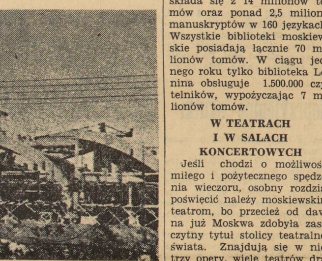
Budowa wielkich zakładów przemysłu bawelnianego w Zambrowie wchodzi w decydujący etap. Na początku 1954 r. rozpocznie się montaż maszyn otrzymanych z ZSRR. Na zdjęciu: fragment budowy hali przędzalni.
