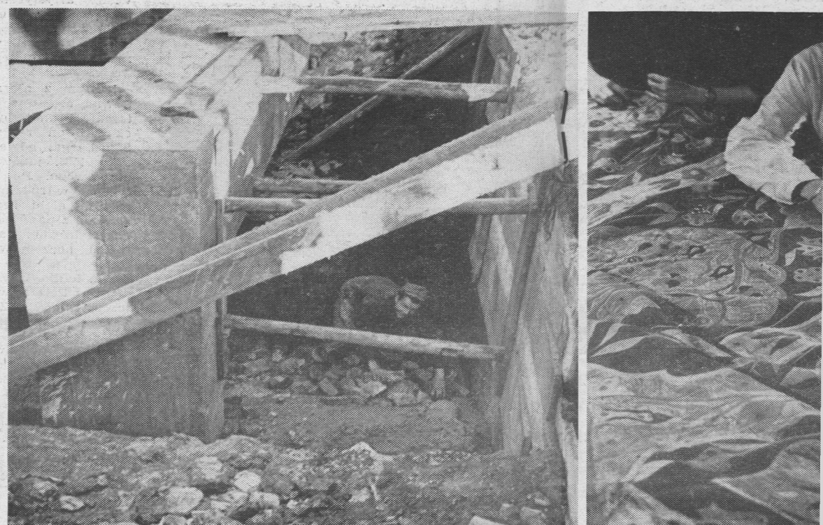
Stara powierzchnia dziedzińca... o półtora metra głębiej.
