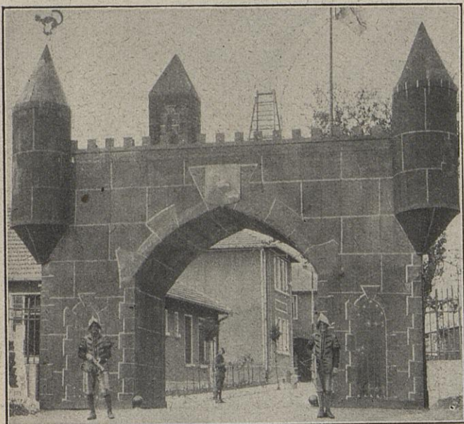
Ein höchst merkwürdiger Torbogen ist über Nacht entstanden. Wachtposten mit Hellebarden stehen davor: Dieses Tor vor Baracken in der Maginot-Linie ist zum französischen Nationalfeiertag geschmückt.
