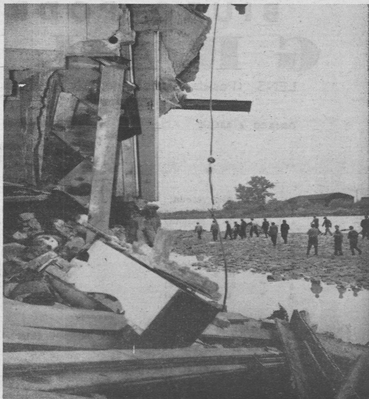
Jak podawaliśmy, Polskę nawiedziła druga fala powodzi, powodując olbrzymie straty materialne. Na zdjęciach: wojsko niesie pomoc powodziarzom w Żywcu; rozszalałe wody Soły; mury domy w Żywcu rezbite przez żywioł.
