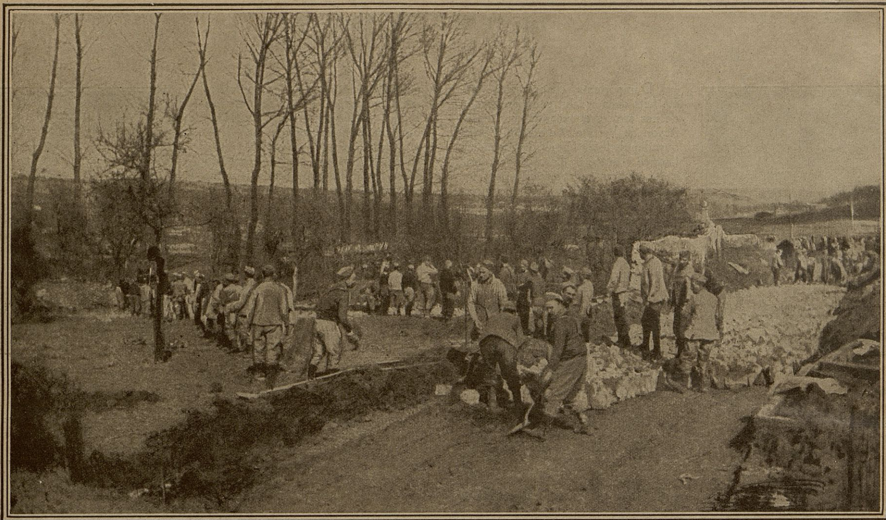
La voie ferrée de Sainte-Menehould étant insuffisante pour amener sur le front de Verdun troupes, munitions et vivres, on a eu recours aux convois automobiles et l'on sait les services qu'ils ont rendus ; des régiments de territoriaux ont été occupés à réparer les routes détériorées par le passage incessant des lourds camions et même à en faire de nouvelles.
