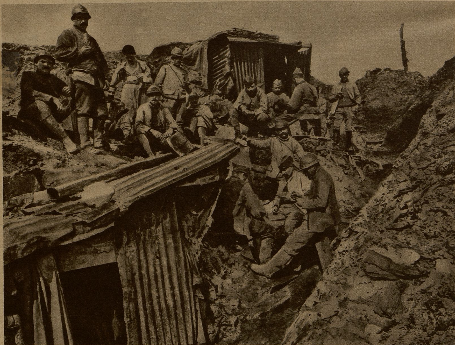
A l'aide de tôles ondulées, de madriers, de rondins recouverts de terre, des abris ont été construits dans les trous d'obus qui criblent le terrain du ravin de près de Verdun ; là nos soldats peuvent trouver un repos relatif après les longues heures de veille passées dans les tranchées, en face d'un ennemi qui multiplie les coups de main sur nos lignes de ce secteur ; ces tentatives sont toujours précédées de bombardements au moyen d'obus à gaz.
