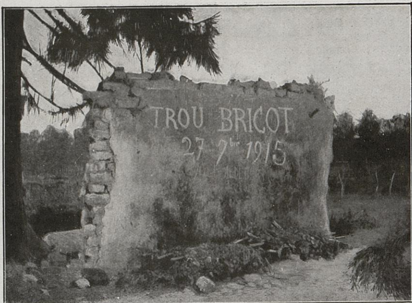
Sur un pan de mur nos braves soldats ont marqué leur passage.
