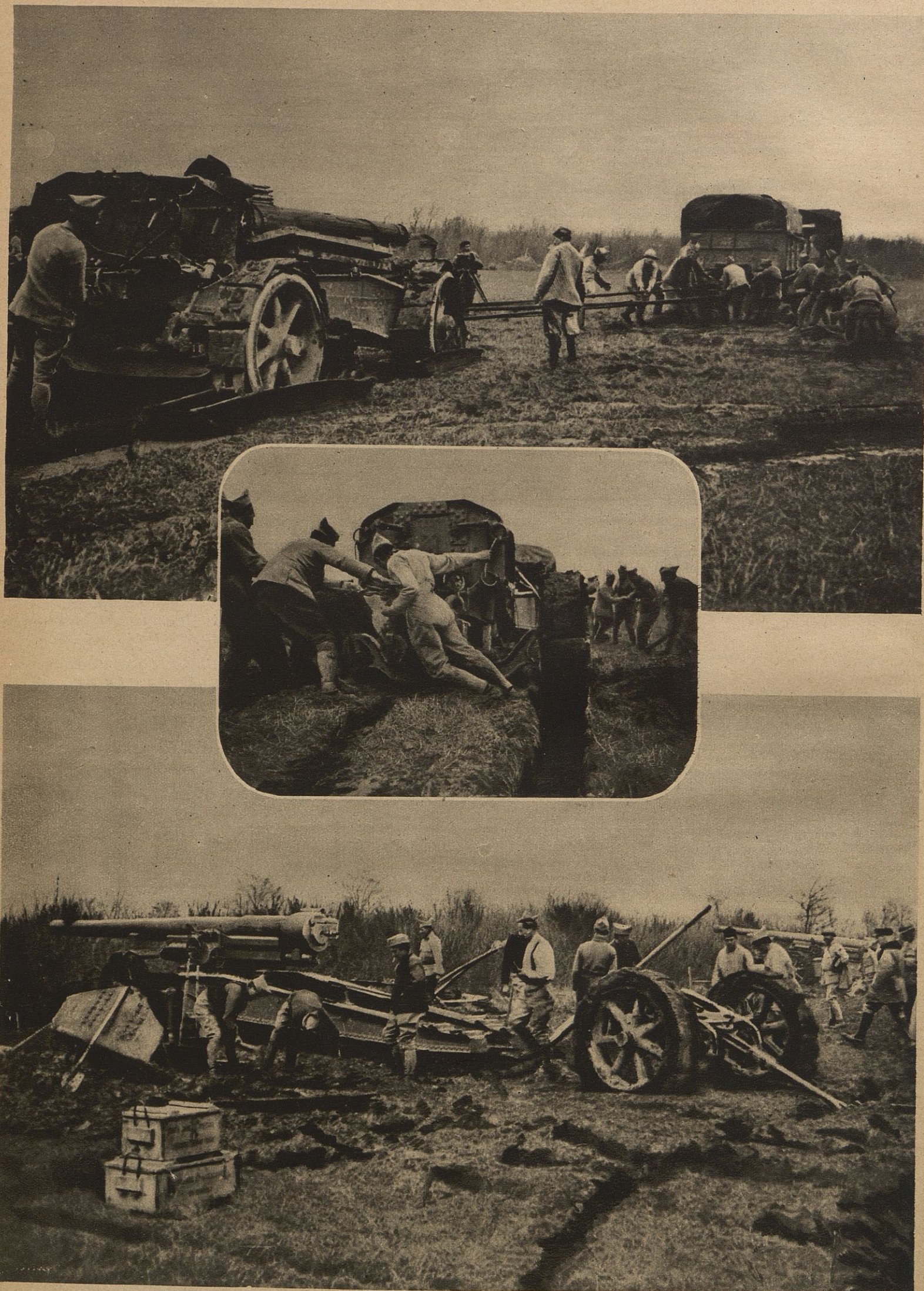
Le nouveau canon à grande portée, le 155 long, ou canon Fillieux du nom de son inventeur, vient de faire ses preuves dans la grande bataille qui se déroule depuis le 21 mars ; son tir est presque aussi rapide que celui du merveilleux 75 ; mais il a sur celui-ci l'avantage de la portée plus longue et de la faculté de se transformer en obusier pour le tir indirect. On voit ici les diverses phases de la mise en batterie de cette excellente pièce.
