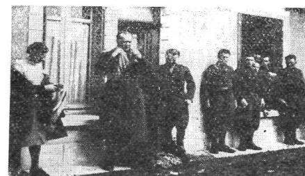
Przed domkiem płk. Ziętkiewicz (drugi z lewej), dzielny dowódca, człowiek, który się „kulom nie kłaniał”
