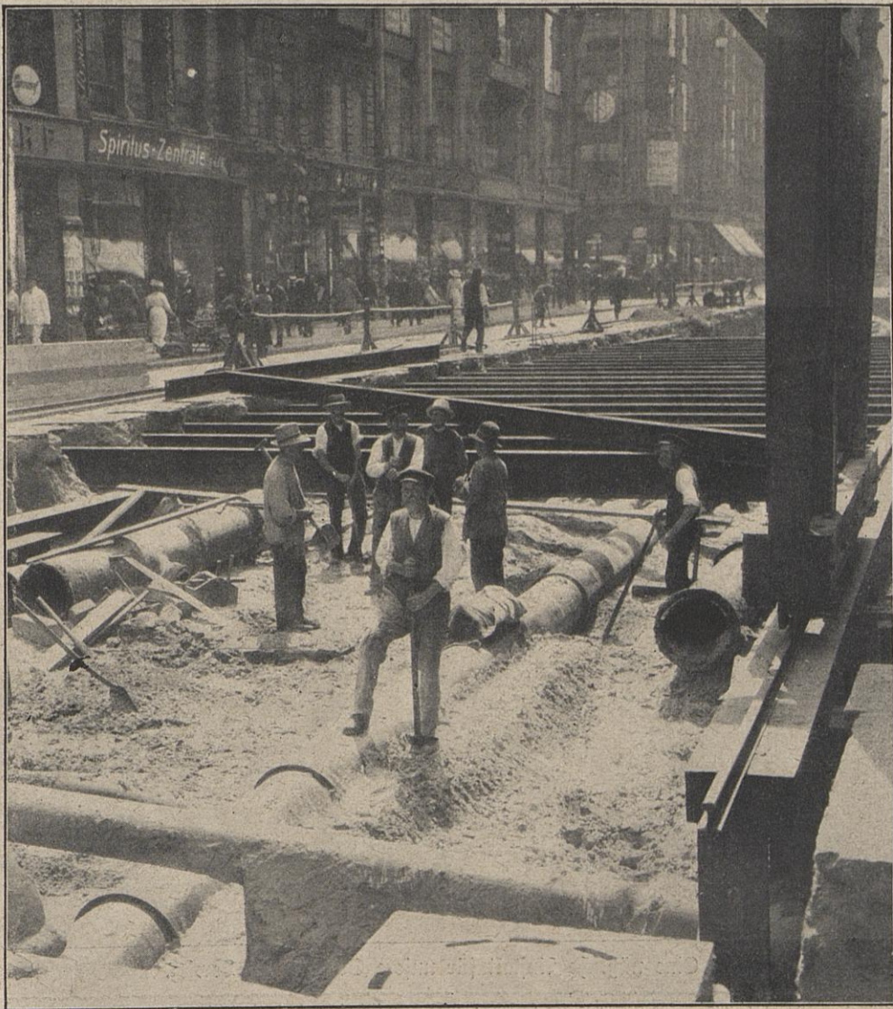
Ein Bild für die Berliner im Felde: Wie die Friedrichstraße jetzt aussieht. Bau der Untergrundbahn.
