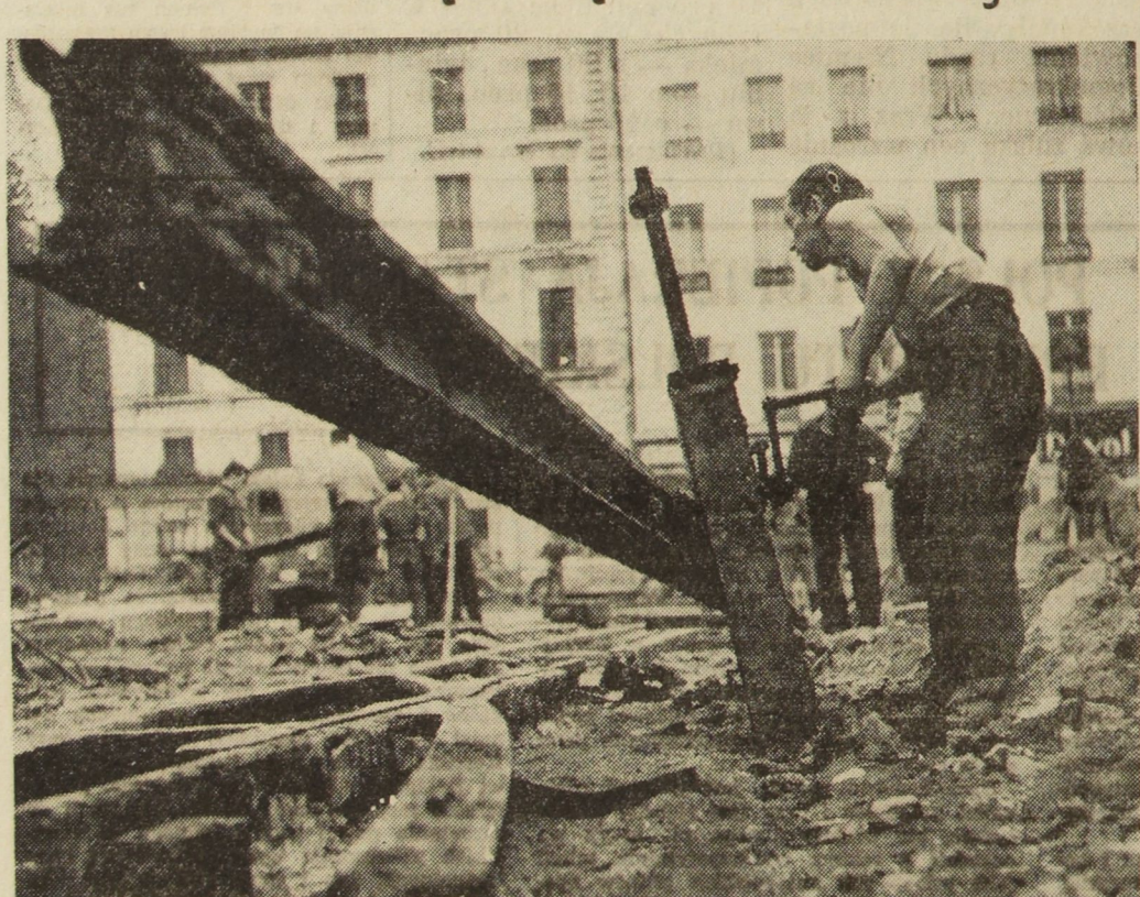
Na placu Madeleine w Paryżu przeprowadzane są wielkie roboty, celem umożliwienia tam postoju licznym samochodom. W ramach tych robót wyrwane są stare szyny tramwajowe, oraz drewniane kostki brukowe. Na zdjęciu: moment tych robót. (Fot. ADP)
