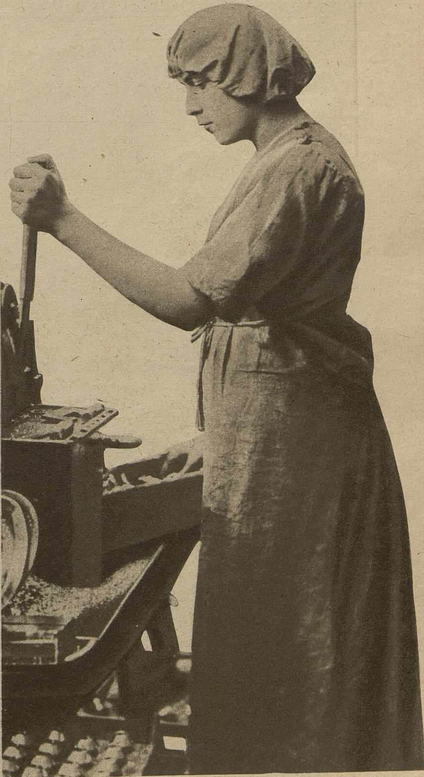
*Tournage du coin de forcement de la douille.*
