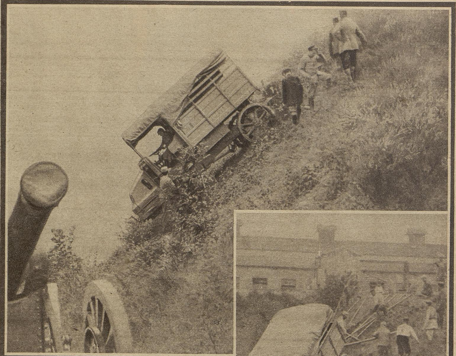
Tracteur "Latil" se halant lui-même par l'arrière, à l'aide de son ca bestan, sur une pente de 85 centimètres par mètre.
