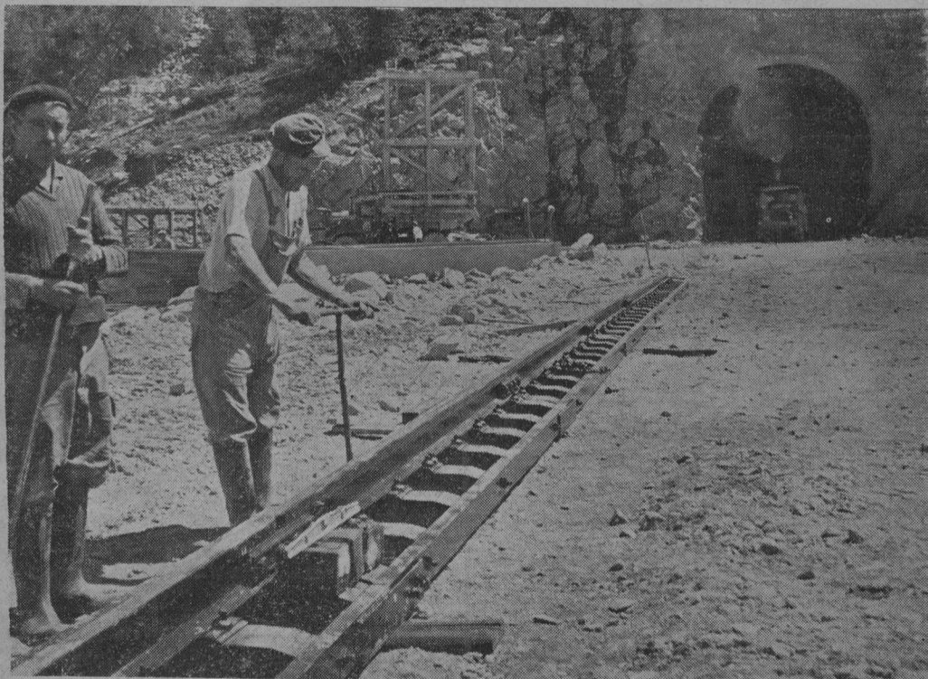
PRACE PRZY TUNELU POD MONT - BLANC OD STRONY FRANCUSKIEJ
