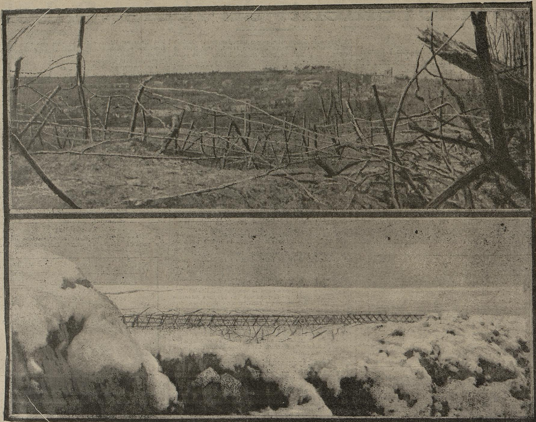
En haut, une vue de Craonne, prise à travers les fils de fer barbelés qui protègent une de nos tranchées de première ligne. Au-dessous, une ligne de défense construite par nos troupes. On aperçoit, au second plan, la tranchée allemande, et, plus loin, un petit bois occupé par l'ennemi.
