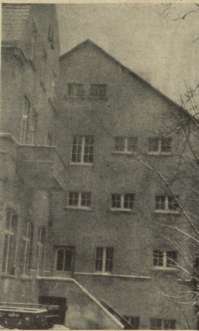
...I Wychodźstwo polskie we Francji przyczynia się w znacznym stopniu do utraty polskości na Ziemiach Zachodnich, poprzez fundację Domu Dziecka w Szczecinie-Zdrojach. Oto fragment głównego gmachu tej budowy.
