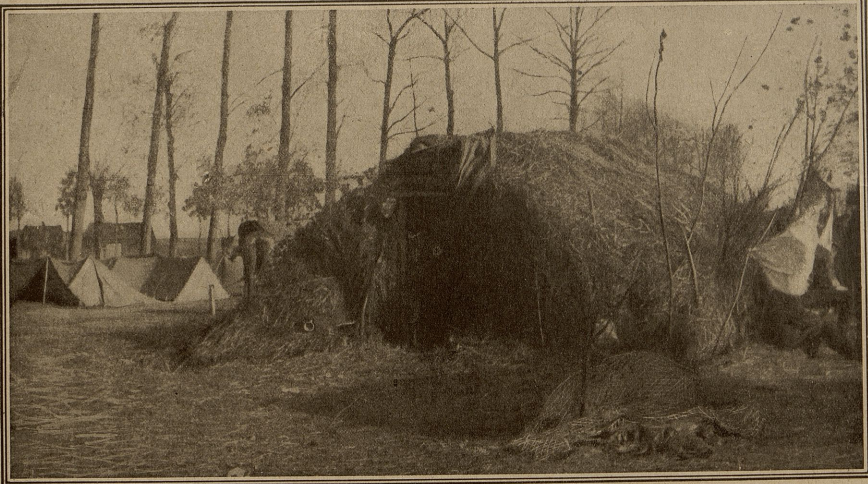
C'est dans une hutte, faite de branchages et recouverte de chaume, qu'on a installé ce poste de secours ; les avantages de cette disposition sont évidents : d'abord, les blessés recevront des soins dans un endroit plus chaud que sous la tente de toile ; puis, le poste sera dissimulé aux yeux de l'ennemi qui s'acharne contre les ambulances.
