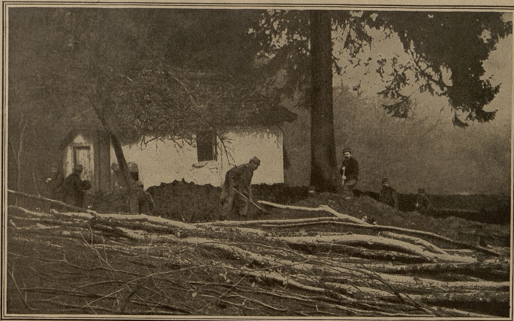
Il faut remuer la terre : à l'aide de pioches, de bêches, de pelles, la tranchée se creuse peu à peu.
