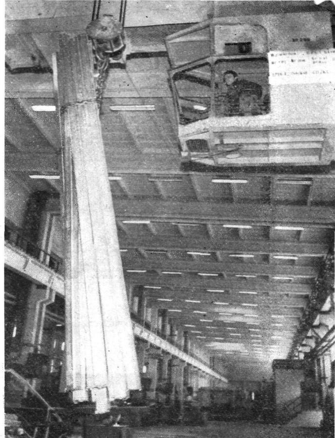
Hala wanień elektrolitycznych zadziwia wielkością. Tutaj (na zdjęciu u góry) na dnie elektrolizatora gromadzi się ciekłe aluminium i stąd za pomocą specjalnych kadzi próżniowych przenoszone jest do dalszej obróbki. Tak zwane wlewki kwadratowe o długości 4 m (na zdjęciu z prawej) uzyskuje się z polskich urządzeń zaprojektowanych i wykonanych przez znakomitych skawińskich fachowców
