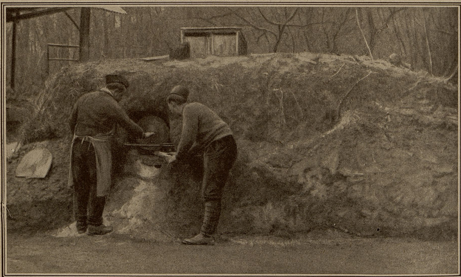
On n'a ni briques, ni terre réfractaire pour construire un four de campagne ; on s'en passera. Un bidon d'essence de 60 litres, enfoncé dans le talus de la route, voilà le four tout construit : il n'y a plus qu'à chauffer.
