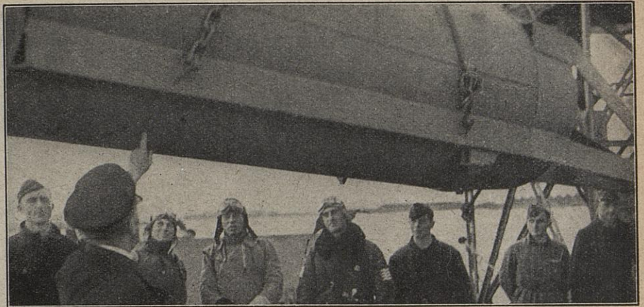
Die Schleuderschützen erhalten Unterricht. Das Geschöß soll katapultiert werden. Es erhält je nach Bedarf eine entsprechende Wasserfüllung und je nach der Wasserfüllung muß die Preßluft beim Abschuß reguliert werden.
