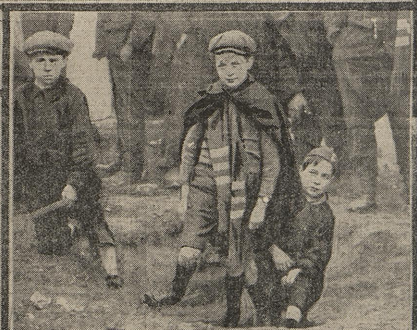
UNE EXCAVATION PRODUITE PAR UNE BOMBE
