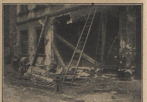
In Ludwigshafen: Zerstörtes Wohnhaus.
