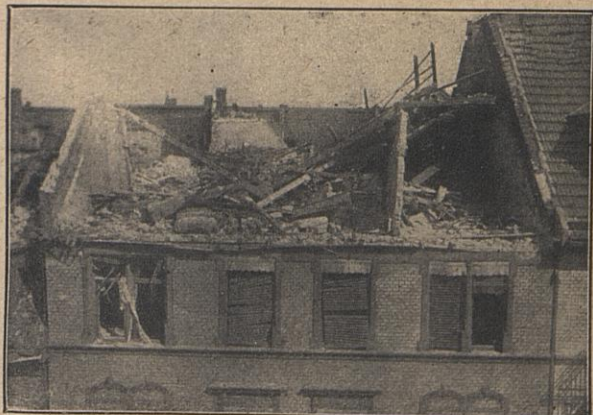
In Mannheim: Zerstörtes Wohnhaus.
