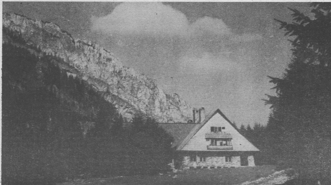
Jednym z ważnych elementów ochrony przyrody jest odpowiednie dostosowanie budownictwa do przyrody. Za wzór dobrych rozwiązań stawiane jest często schronisko na Ornaku.
