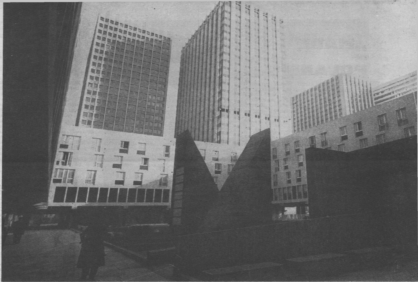
Na pierwszym planie cementowe filary; oprą się na nich ruchome schody
