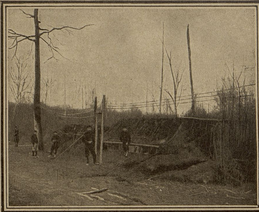
Enfouie dans la terre, cachée par les arbres et par des branchages, se trouve ici une cabane qui est l'un des postes les plus importants du commandement d'artillerie. Des fils téléphoniques le relient aux différentes batteries et aux postes des observateurs ; de là partent les ordres qui lancent la mitraille sur l'ennemi
