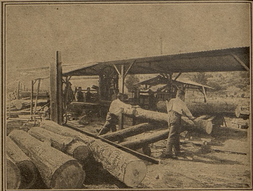
Des arbres entiers sont débités par la scierie ; amenés des forêts voisines au moyen de grands chariots, les troncs d'arbre sont poussés sous la grande scie qui les découpe en morceaux de la longueur marquée par les officiers du génie.
