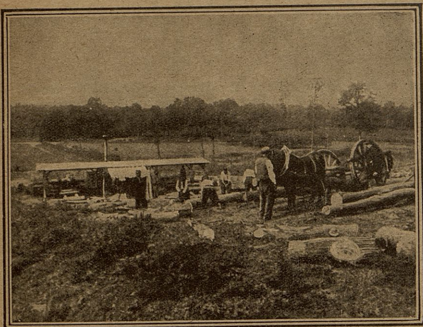
A l'arrière des lignes de combat sont installés de véritables chantiers pour les services de l'armée ; ici c'est une scierie mécanique où l'on prépare les rondins qui serviront à étayer solidement les tranchées et les abris souterrains.
